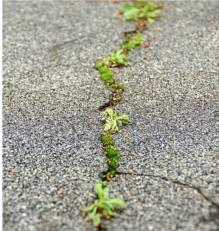
Auch durch die Gesellschaft ziehen sich immer mehr Risse. Können sie nicht repariert werden, droht der Totalschaden.
